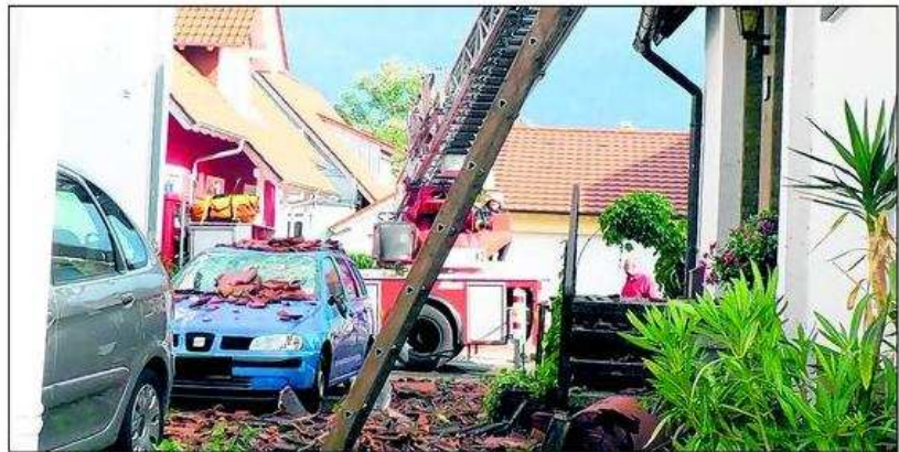
Die Windhose richtete viele Schäden an. Verletzt wurde durch das Unwetter niemand.
